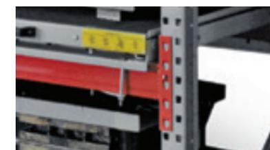
Крепление балки к стойке
